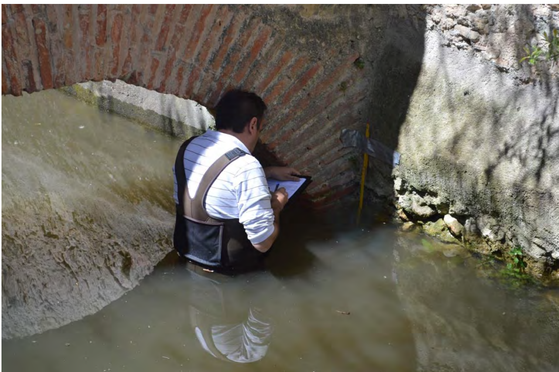
Final del ensayo de llenado en el canal de Herrera. Punto 2
