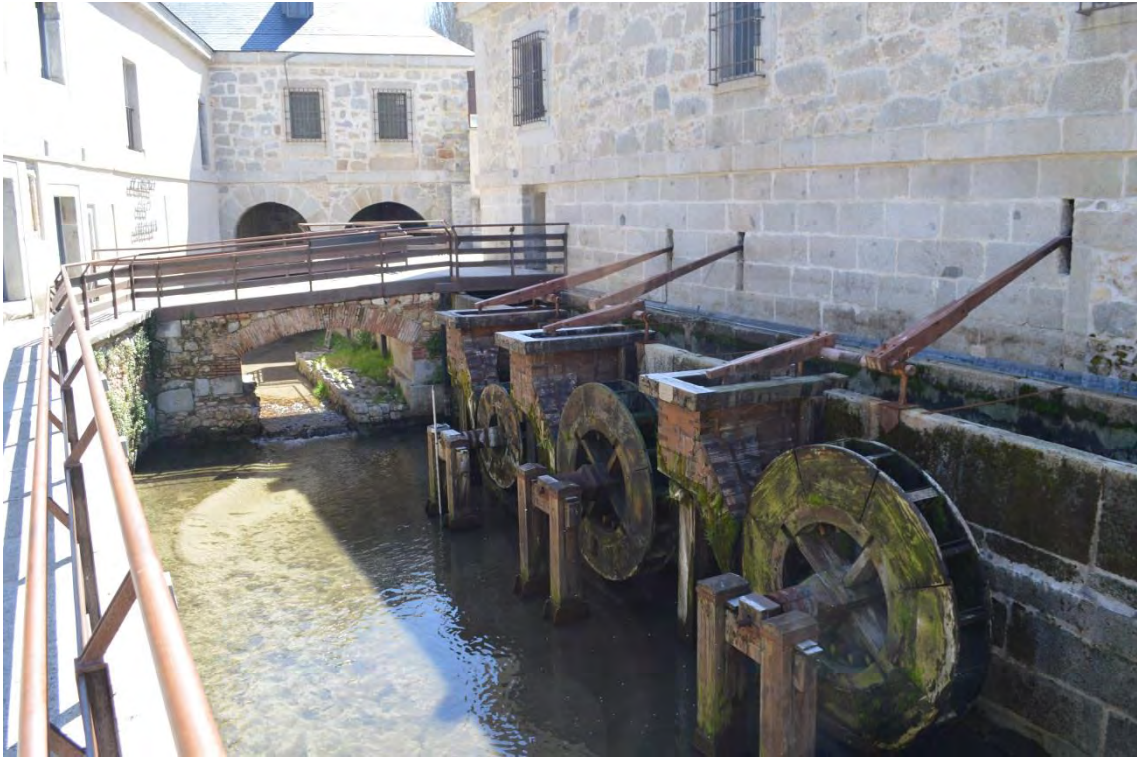
Sistema de canales (canal de Herrera y canal de Sabatini) aguas arriba
