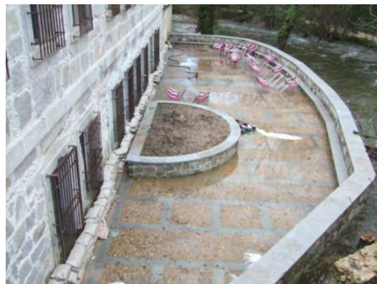
Figura 1.2.11. Vista de la terraza del bar-restaurant Ingenio Chico tras el bombeo del agua acumulada tras el muro perimetral y con los sacos terreros en puertas y ventanas para tratar de prevenir otras posibles inundaciones.
