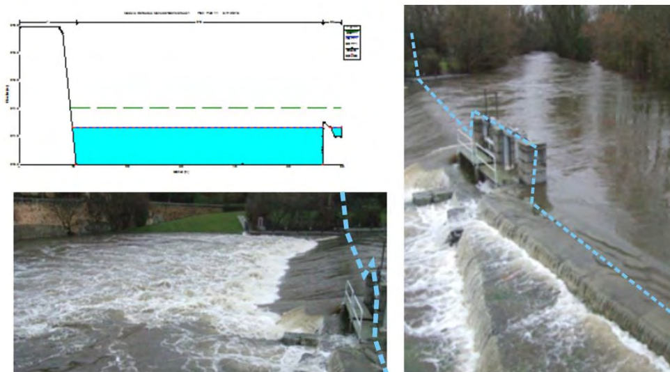
Figura 1.2.41. Sección transversal inicial del modelo HEC-RAS, correspondiente al azud de la RCMS, correspondiente al caudal punta del 2014 (arriba izquierda); y fotografías de la realidad observada para ese evento.
