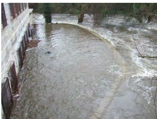
Figura 1.2.16. Vista de la terraza del bar-restaurante Ingenio Chico en el momento de circulación de la punta máxima de caudal de la avenida, el 2 de marzo de 2014 a las 8:00 h. Obsérvese el efecto de represamiento y elevación de nivel que produce el muro perimetral de la terraza.
