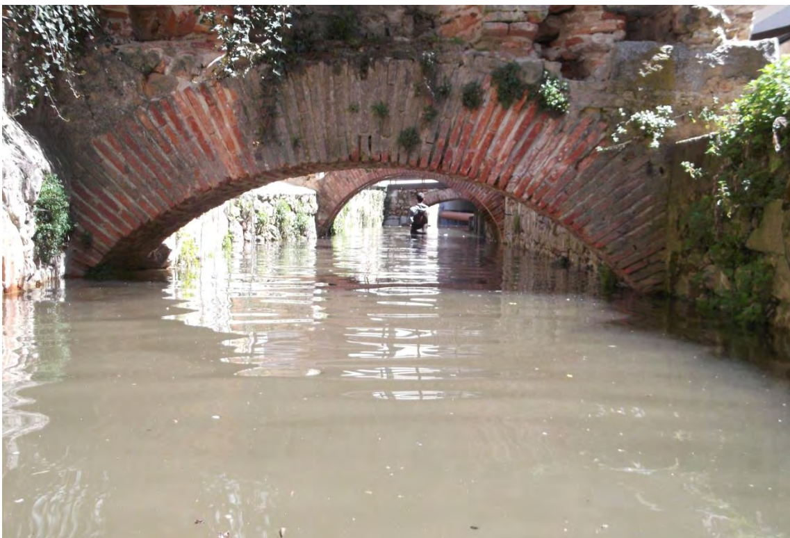
Final del ensayo de llenado en el canal de Herrera
