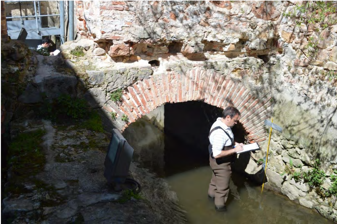
Inicio del ensayo de llenado en el canal de Herrera. Punto 2
