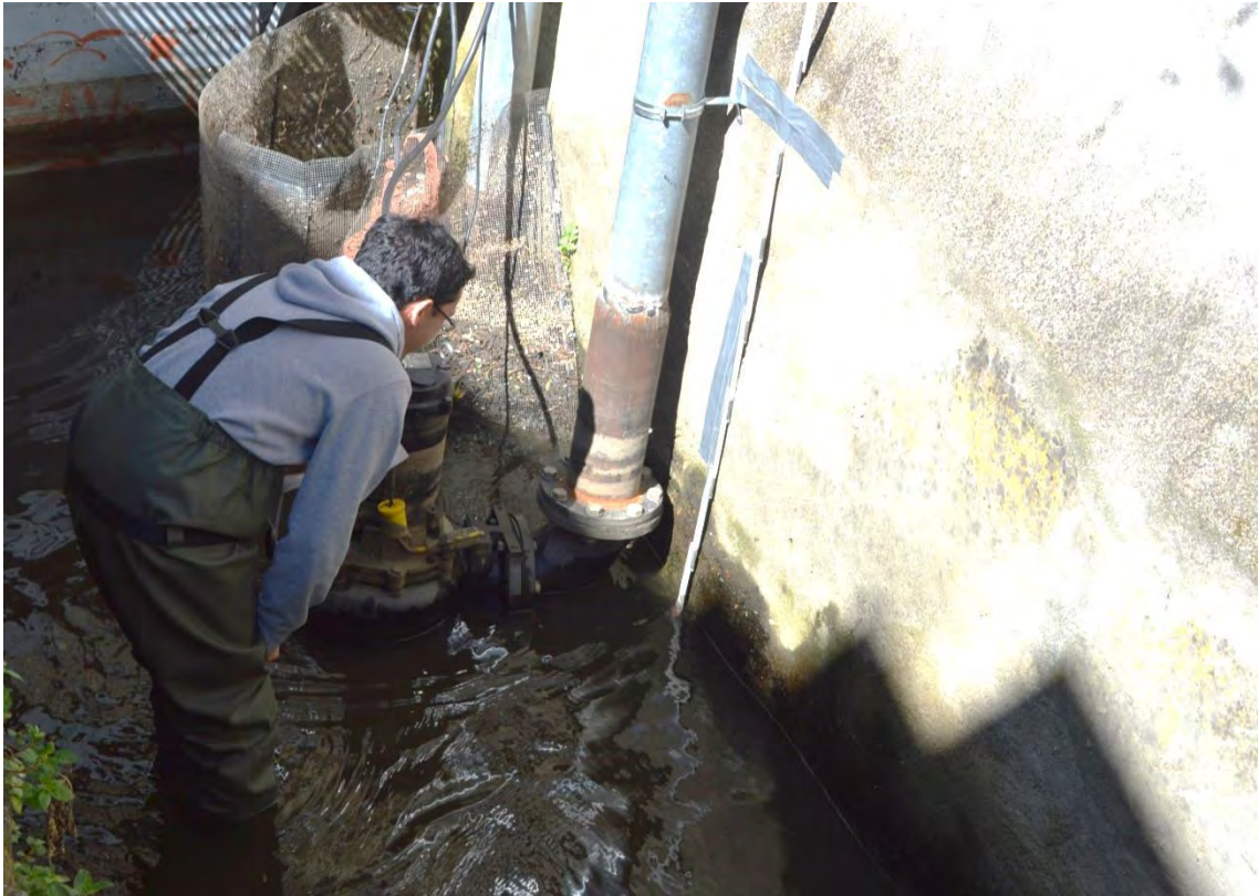
Inicio del ensayo de llenado en el canal de Herrera. Punto 1
