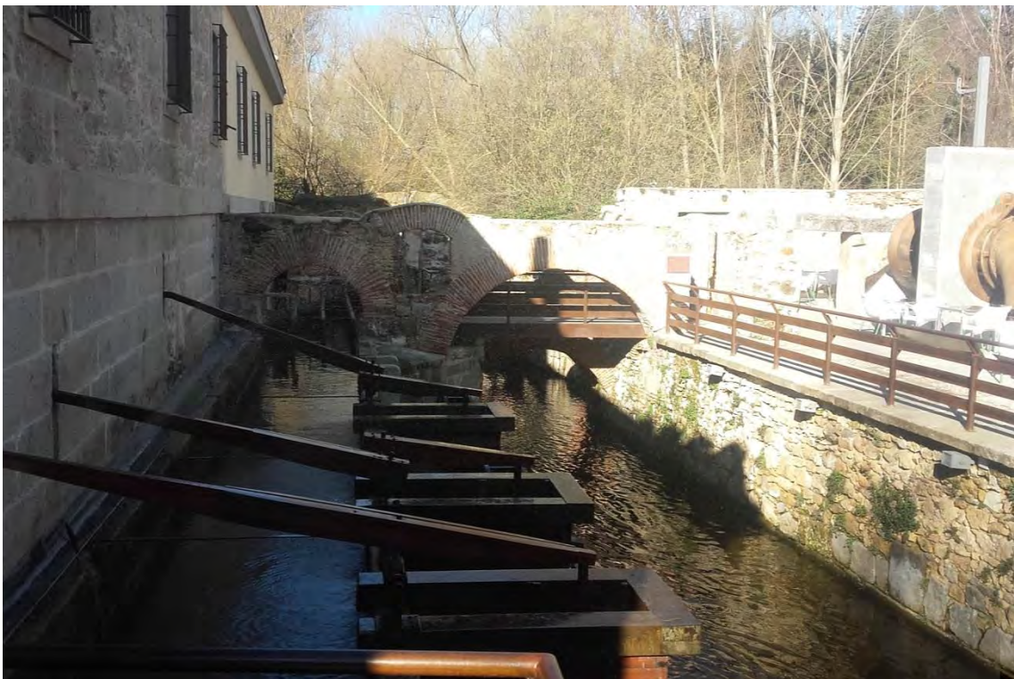
Sistema de canales (canal de Herrera y canal de Sabatini) aguas abajo
